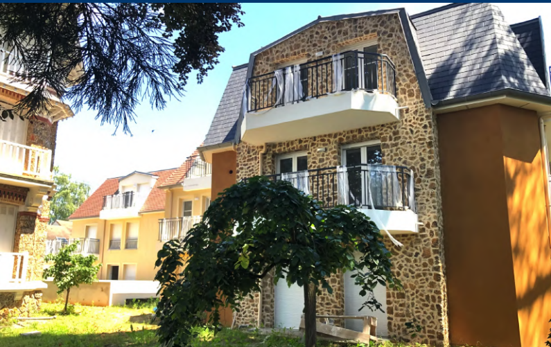
26 logements à Beaumont-sur-Oise Maîtrise d'ouvrage : FourStones 2 358 000 € HT 1488 m 2 SDP
